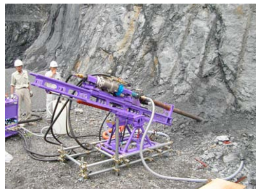
ミストフラッシング使用の削孔状況
